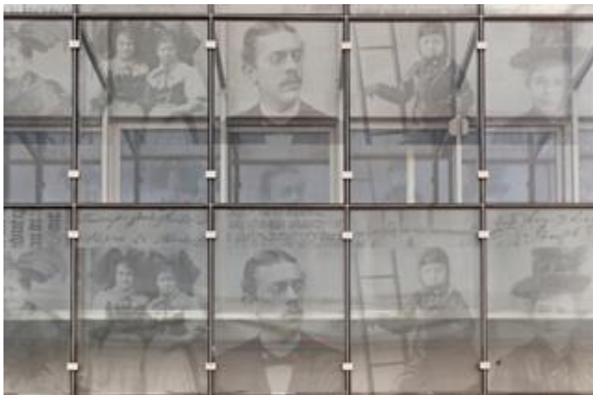
Façade nord du nouveau bâtiment des archives départementales, vue depuis le parking. © Conseil général du Bas-Rhin, Denis Guichot.
